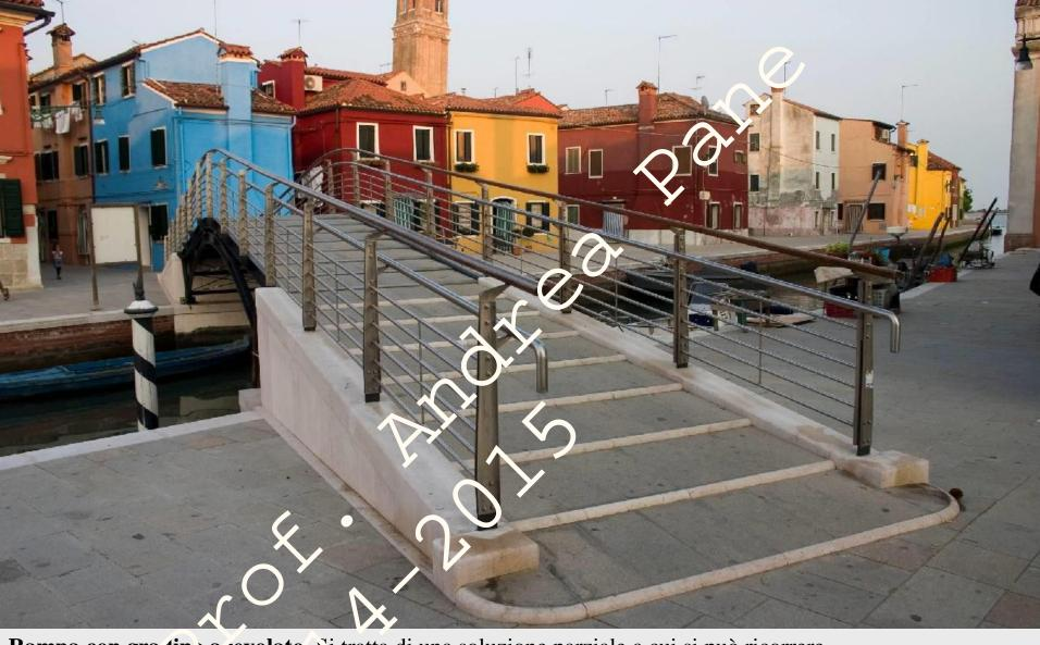
Rampa con gractino agevolato. Si tratta di una soluzione parziale a cui si può ricorrere qualora non sia possibile reguzzare una rampa a norma. La rampa a gradino agevolato presenta gradini con pedato molto profonde e alzate di limitato spessore (circa 8 cm) con profilo a toro smussato. Risulta accessibile alle persone su sedia a ruote, purché in presenza di accompagnatore, o se dotate di carrozzina elettrica.
