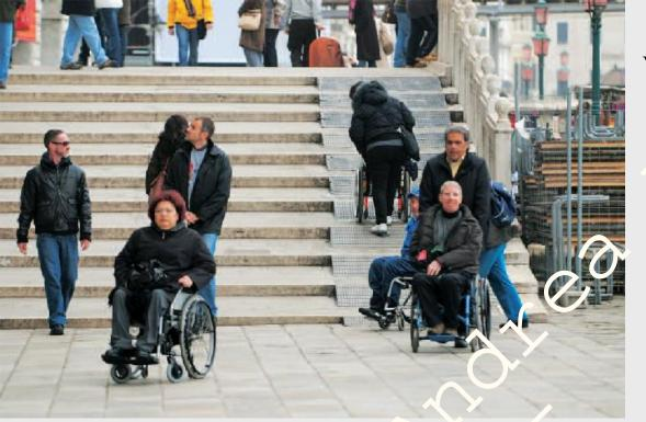
Venezia, Ponte della Paglia. La rampa è costituita da una pedana componibile in elementi di materiale plastico trattato antisdrucciolo. Per la facilità di montaggio e per la sua totale reversibilità, può rappresentare una soluzione per varie situazioni in cui sia necessario superare uno o due gradini, sia all'interno che all'esterno di edifici storici.
