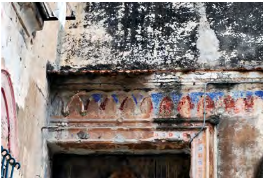
Particolare della fascia di archi intrecciati con tracce di intonaco rosso e azzurro visibile sul prospetto principale
