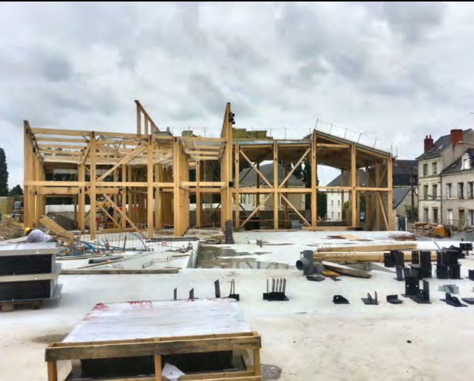
“Loft cinémas”, Châtellerault per Gilbert Long Architectures, 2013. Montaggio della carpenteria in legno
