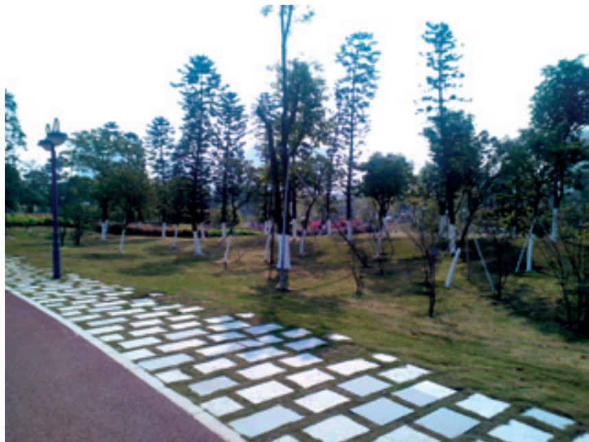
Cantiere nuova città di Foshan
